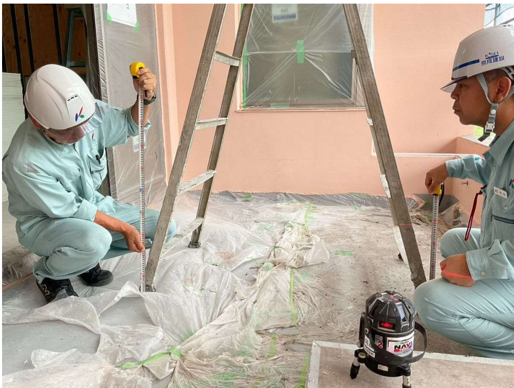
脚立使用状況確認 高低差20mm
